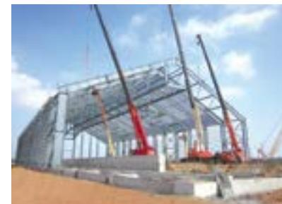
Khung nhà thép tiền chế được làm từ thép tiêu chuẩn lưu trữ sẵn trong kho của nhà sản xuất. Khung nhà thép tiền chế thường được thiết kế dạng vát, có bản cáp và bụng với độ dày khác nhau tại từng phần riêng biệt.
