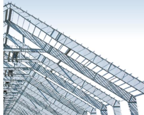
お客様の設計およびエンジニアリング与件に準拠した単品生産の鉄骨建築。応力の小さい部位の鉄骨量を減らす、テーバーをつけた組み立て部材を使用し経済性の最大化を実現しました。PEBは、60mまでのスパンで、軒高30mまでの低層建築において最適かつ最も経済的なものとなっています。
