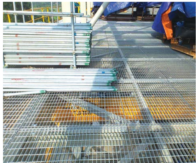
SÀN LƯỚI THÉP LIÊN KẾT VỚI DẦM PHỤ MEZZANINE GRATING CONNECTION TO JOIST
