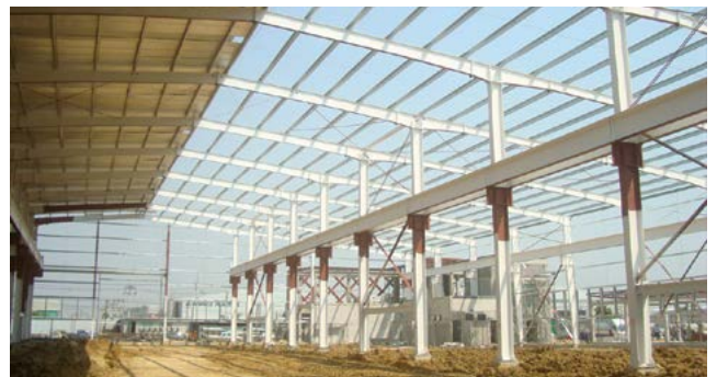
GIẪNG THÉP TRÒN ROD BRACING
