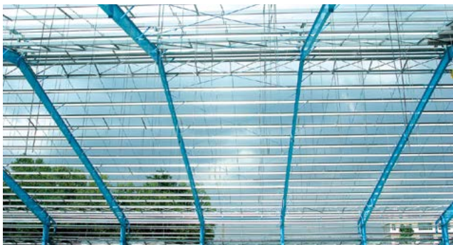
GIẪNG CÁP CABLE BRACING
