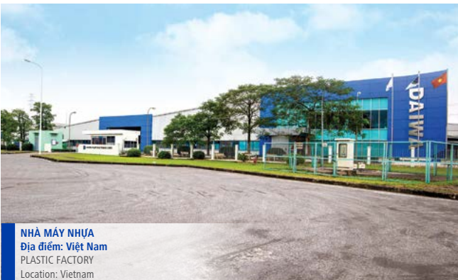
NHÀ MÁY NHỰA Địa điểm: Việt Nam PLASTIC FACTORY Location: Vietnam
