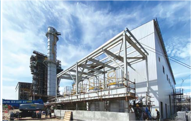
NHÀ MÁY ĐIỆN TUA-BIN KHÍ CHU TRÌNH HỖN HỢP Địa điểm: Malaysia • Khối lượng: 3.329 tấn CYCLE POWER PLANT Location: Malaysia • Weight: 3,329 MT
